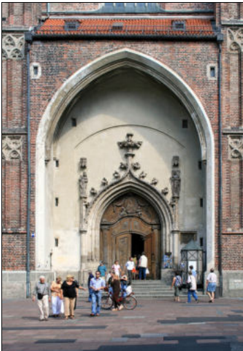
Das Hauptportal der Frauenkirche – ausnahmsweise ohne Baugerüst
